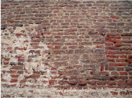
Afb. 6.8a Oostelijk schietgat F14 met dichtzetting F11 (buitenzijde van de toren). Foto genomen richting het westen.
