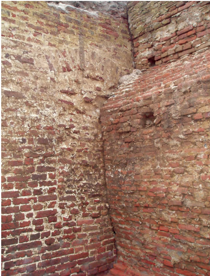
Afb. 6.6 De doorgang in de stadsmuur (F27) en de latere dichtzetting (F28). De bastionmuur (rechts) is hier tegenaan gezet. Foto genomen richting het noordoosten.
