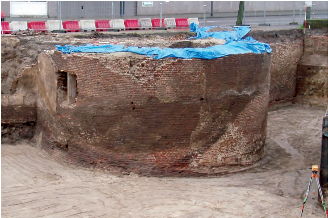
Afb. 6.7 Overzicht van het muurwerk. Foto genomen richting het noordoosten.
