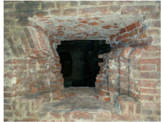
Afb. 6.8b Oostelijk schietgat F14 na verwijdering van dichtzetting F11 (buitenzijde van de toren). Foto genomen richting het westen.
