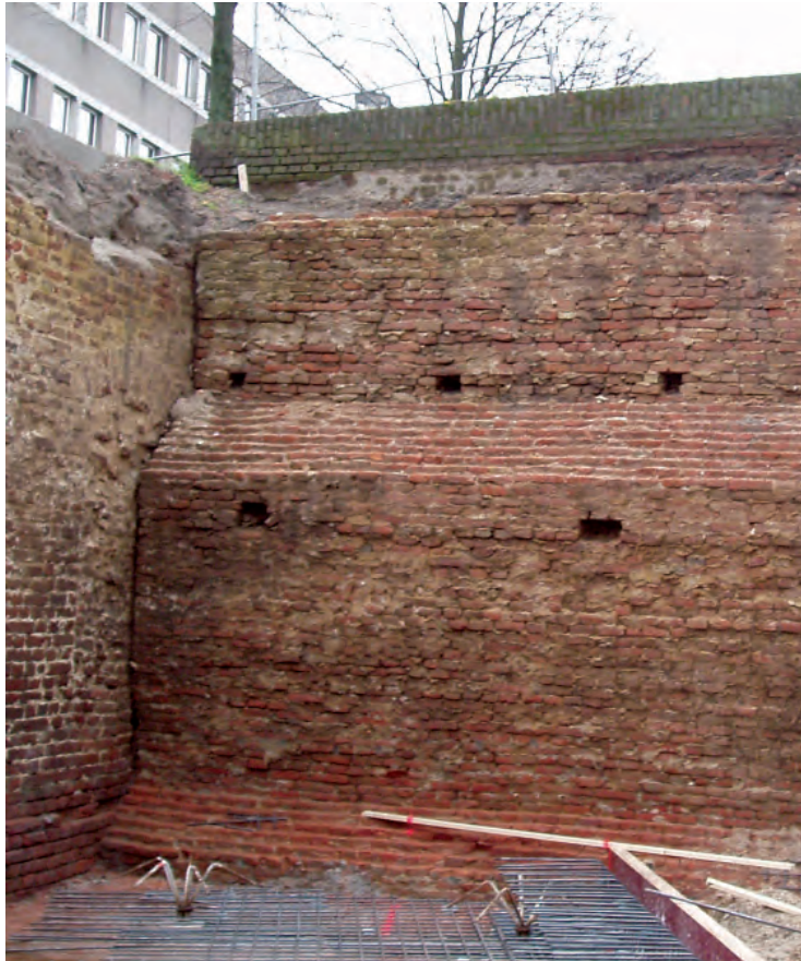
Afb. 6.10 Bastionmuur. Foto genomen richting het noordoosten.
