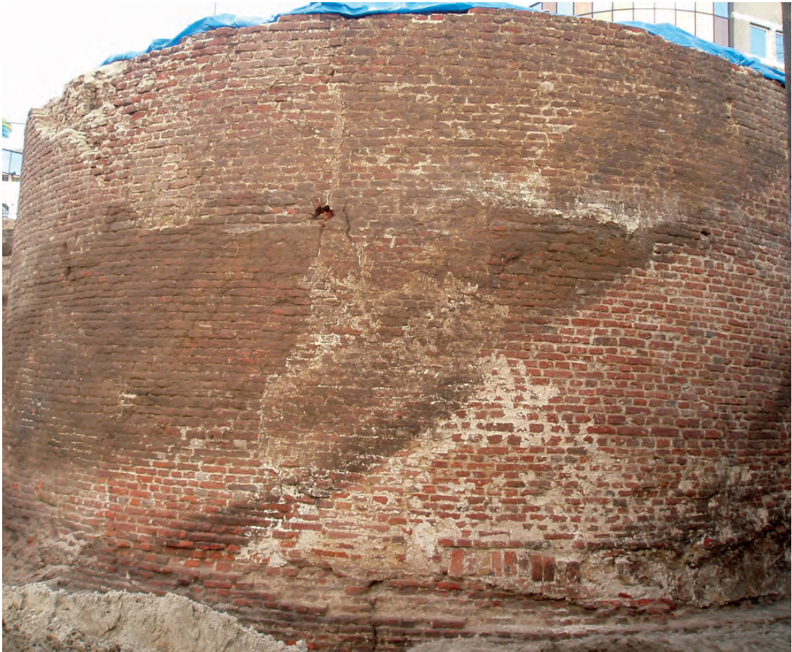
Afb. 6.11 De buitenkant van de toren met de afdruk van laag F108. Foto genomen richting het noorden.
